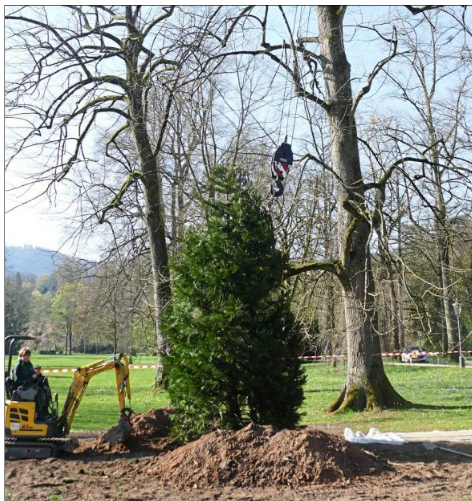
EIN NEUER BAUMRIESE wächst jetzt da, wo das alte Exemplar mit dem Baumfenster erst kurz vorher entfernt wurde. Foto: Krause-Dimmock
